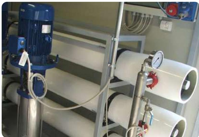
Membrane per abbattimento azoto nel digestato con osmosi inversa
