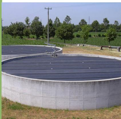
Stoccaggio coperto del digestato
